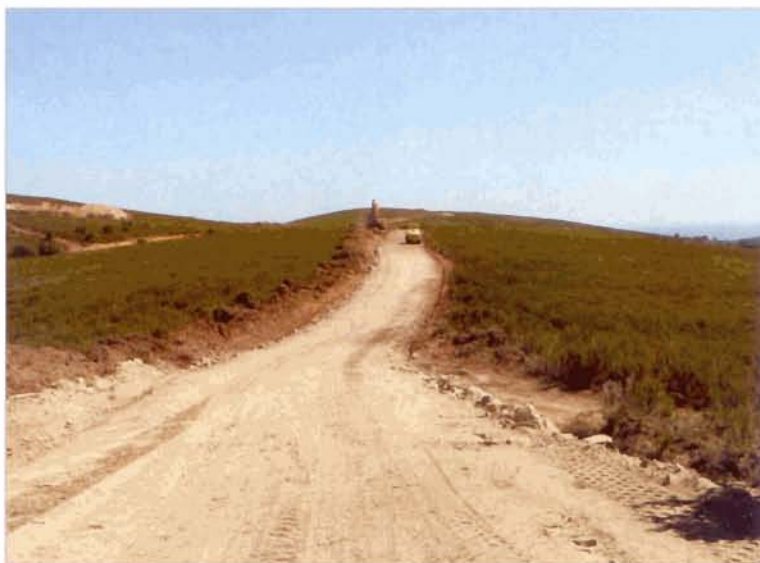
Pista de acceso a las obras del parque eólico de Valdesamario, en una zona de la comarca de Omaña donde está acreditada la presencia de urogallo cantábrico.
